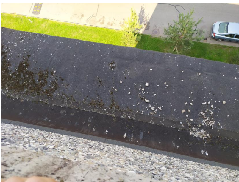
4.9.1.att. Jumts virs lodžijām. Ir jumta seguma bojājumi – ruberoīda plaisas
