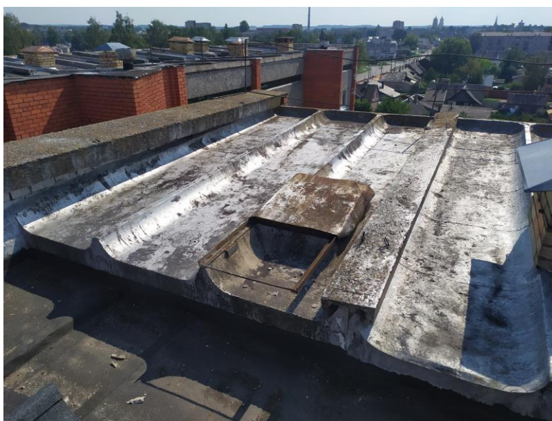
4.13.2.att. Jumta lūka ir sarūsējuša un nav ergonomiska ekspluatācijai. Nepieciešama nomaiņa
