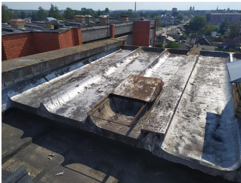
4.8.8.att. Jumta lūka ir sarūšējuša un nav ergonomiska ekspluatācijai. Nepieciešama nomaiņa
