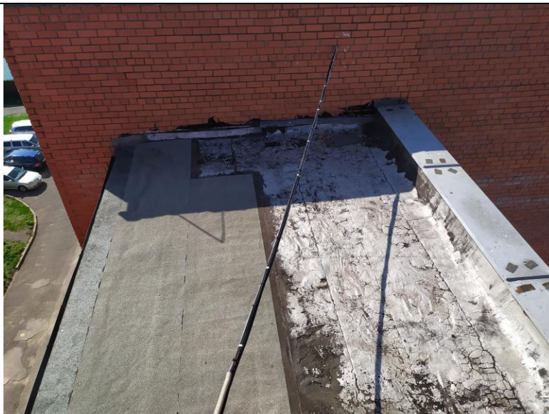
4.9.4.att. Jumts virs lodžijām (lodžiju bloks starp divām ēkas sekcijām). Ir jumta seguma bojājumi – ruberoīda plaisas
