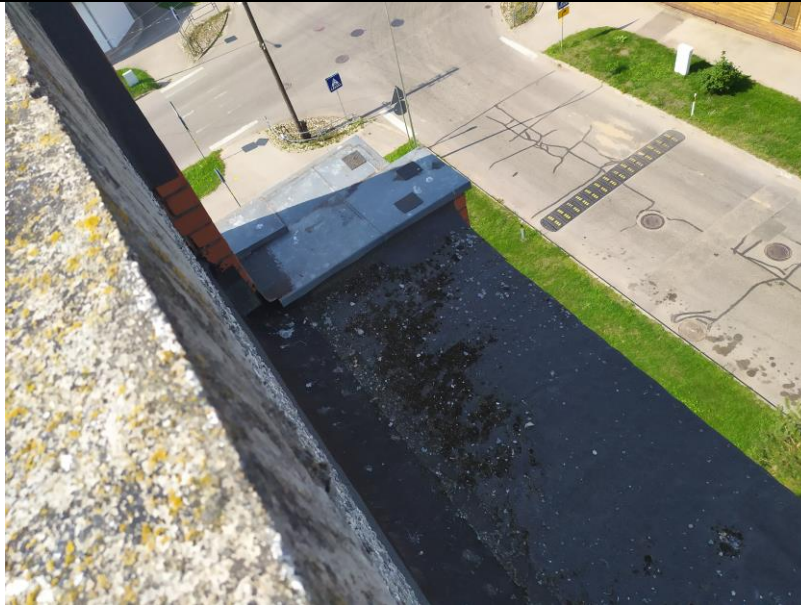
4.9.2.att. Jumts virs lodžijām. Ir jumta seguma bojājumi – ruberoīda plaisas
