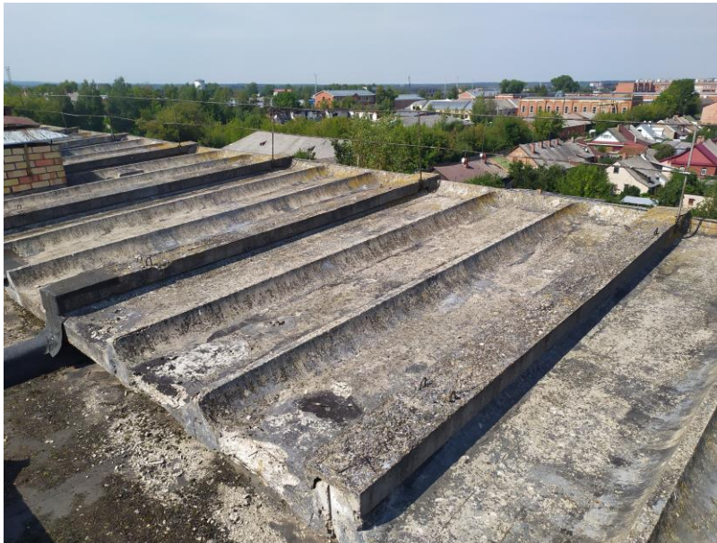
4.8.5. att. Jumta seguma bojājumi
