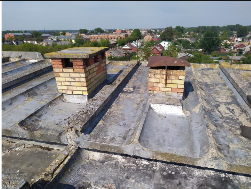
4.8.7. att. Jumta vedināšanas kanāla izvadi ar skārda jumtiņu un betona vāku.
