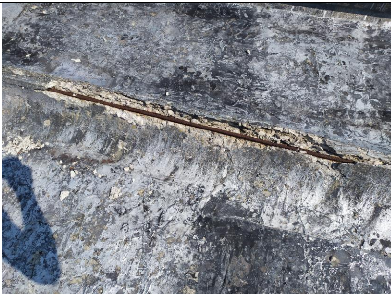
4.8.3. att. Jumta paneļu betona slāņa bojājumi. Stiegrojuma korozija
