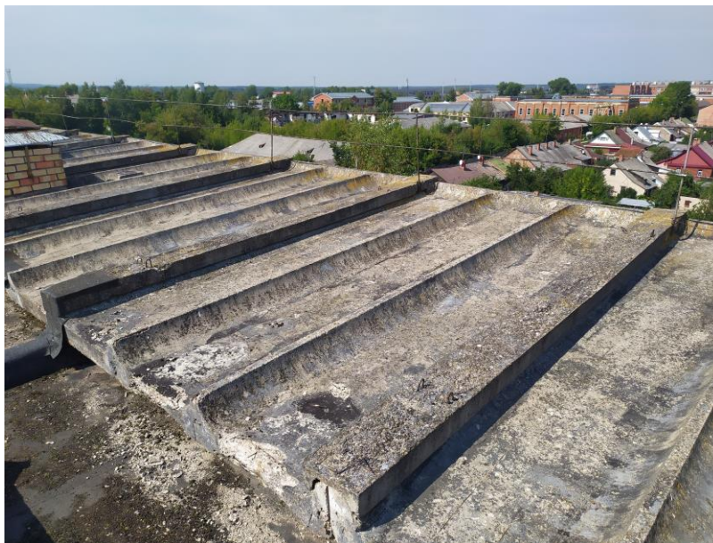
4.8.2. att. Jumta paneļu betona sļāna bojājumi. Stiegrojuma korozija
