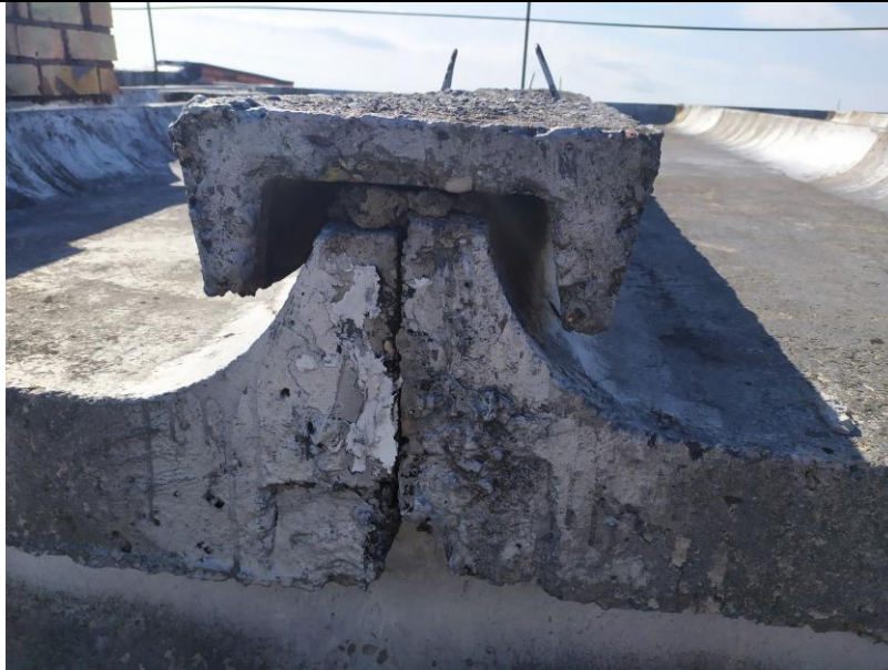
4.8.6. att. Betona aizsargcepure uz paneļu sadurvietām.
