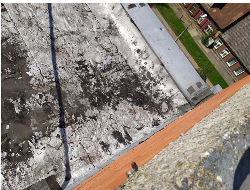
4.9.4.att. Jumts virs lodžijām (lodžiju bloks starp divām ēkas sekcijām). Ir jumta seguma bojājumi – ruberoīda plaisas
