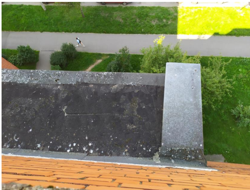
4.9.3.att. Jumts virs lodžijām. Ir jumta seguma bojājumi – ruberoīda plaisas
