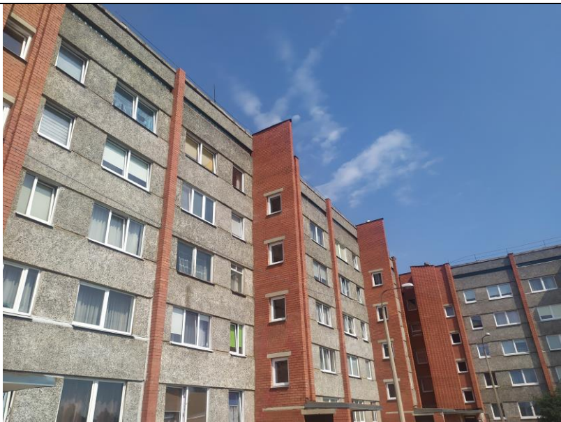
4.13.1. att. Ailu aizpildījums – PVC un koka konstrukcijas logi
