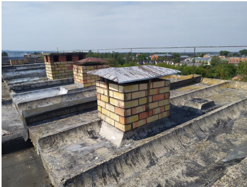
4.8.6. att. Jumta vedināšanas kanāla izvadi ar skārda jumtiņu
