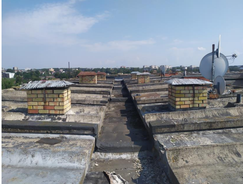
4.8.4. att. Jumta seguma bojājumi
