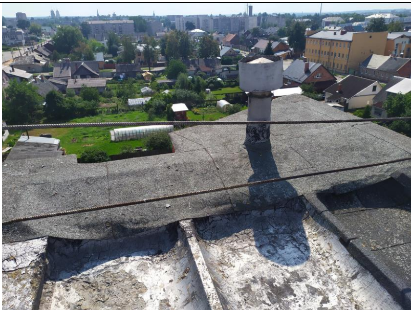
4.8.7. att. Skārda izvads no atkritumu stāvvada. Apmierinoša stāvoklī..
