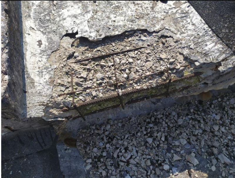
4.8.1. att. Jumta paneļu betona sļāna bojājumi. Stiegrojuma korozija
