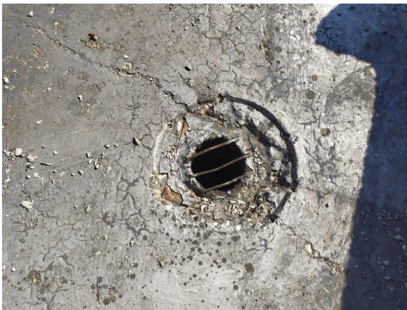
4.8.3.att. Lietus ūdens notek sistēmas piltuvēm (tērauda izstrādājums) ir korozijas pazīmes. Rekomendējams nomainīt uz mūsdienīgām konstrukcijām ar aizsargnorobežojošām konstrukcijām pret piesārņošanu.
